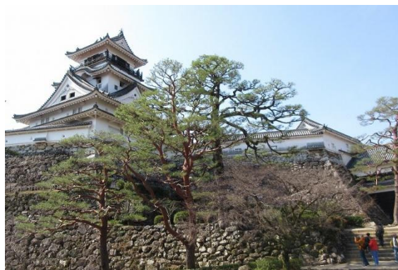
山内一豊が土佐藩に国替えになった際に築城した「高知城」。現存12天守のひとつで重要文化財。旧国宝です。
